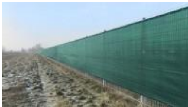
Abbildung 5: Beispiel eines Anlagenzauns mit Sichtschutzblenden - Quelle: accura-fachhandel.de
